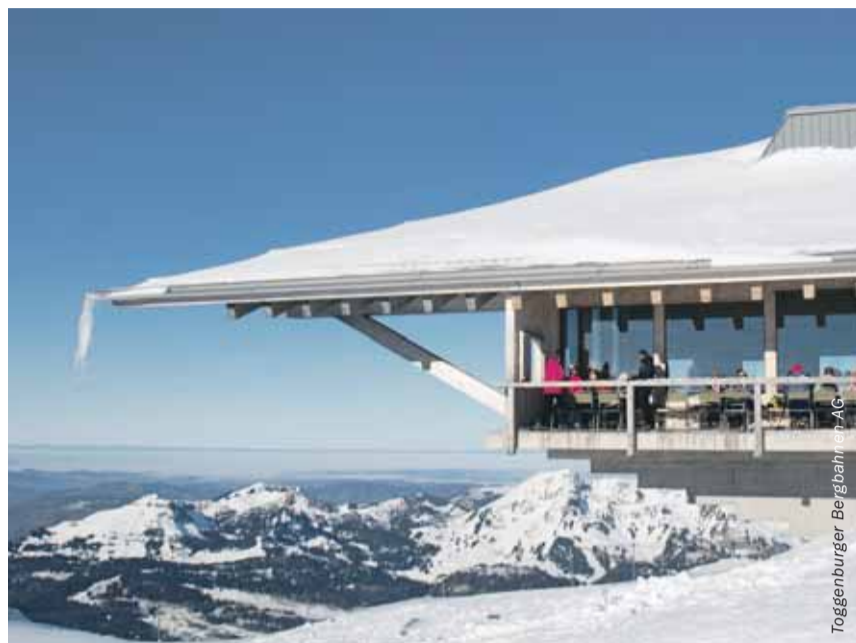
Die Bergstation Chäserugg wurde 2015 von Herzog & de Meuron saniert.
